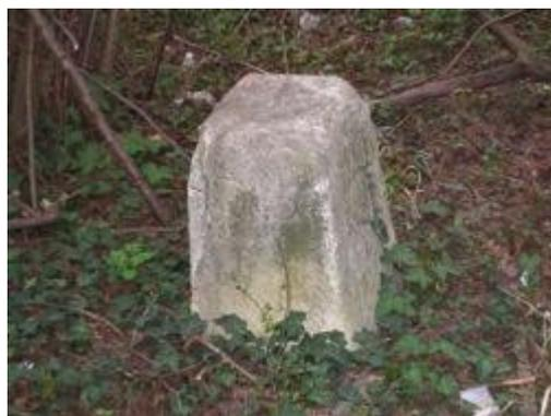
Borne de section carrée, faces pyramidales à tête plate (BF75)
